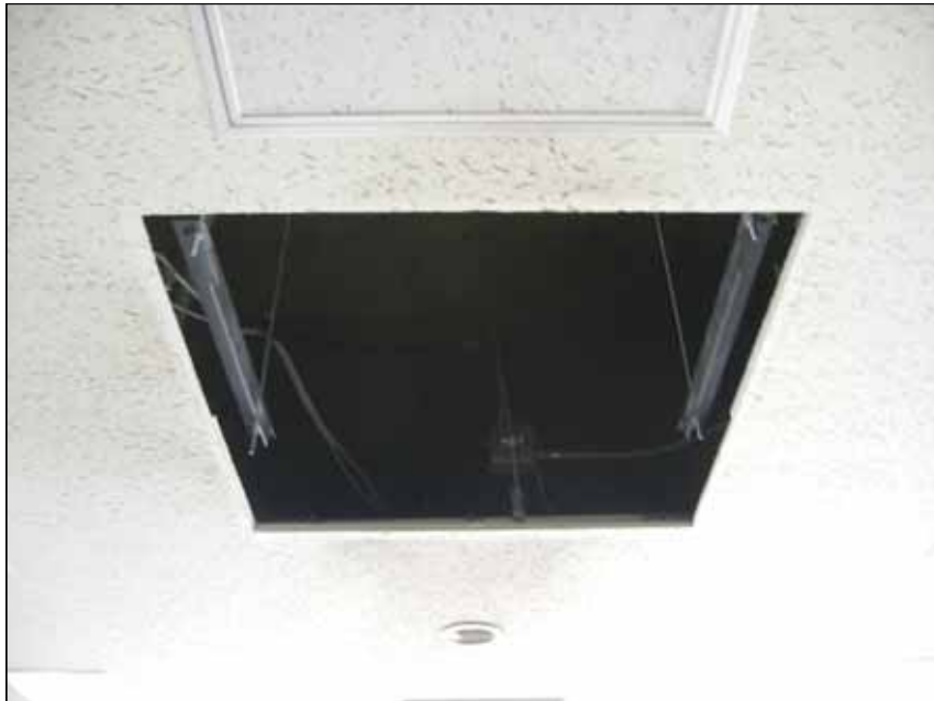
機器：エアコン室内機 作業内容：取外し後
