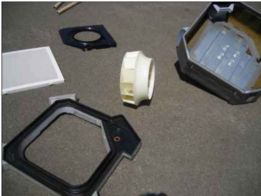
機器：エアコン室内機 作業内容：洗浄後
