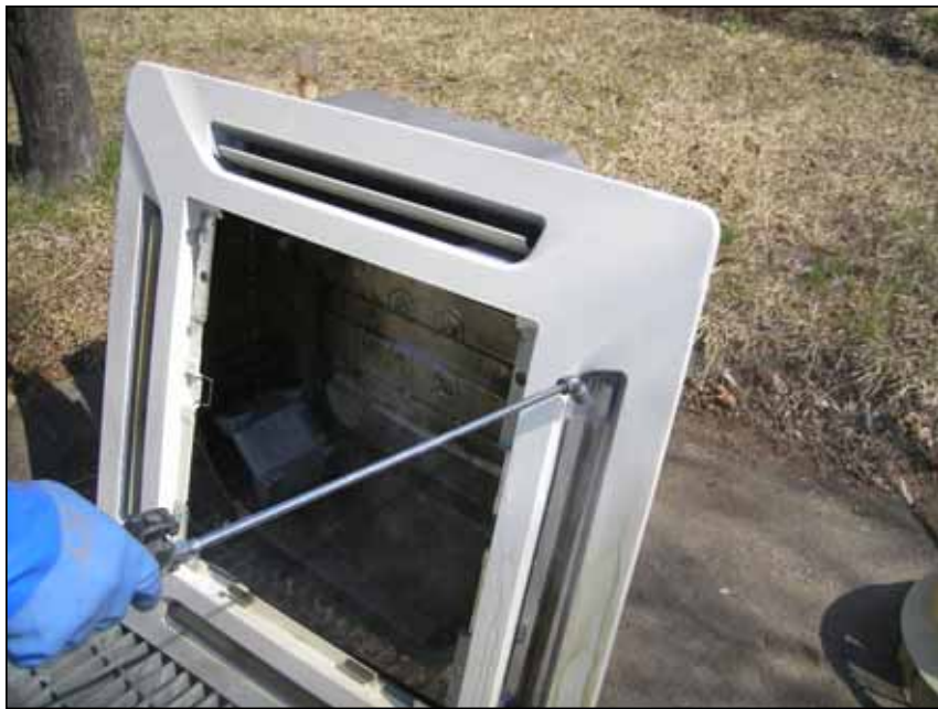
機器：エアコン室内機 作業内容：パネル洗浄中
