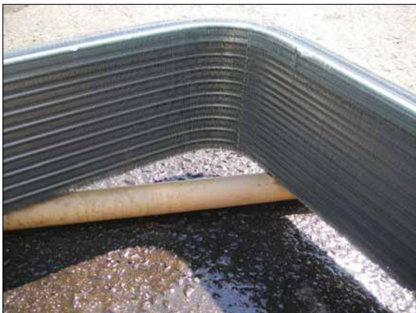
機器：エアコン室内機 作業内容：オイル薬品洗浄後
