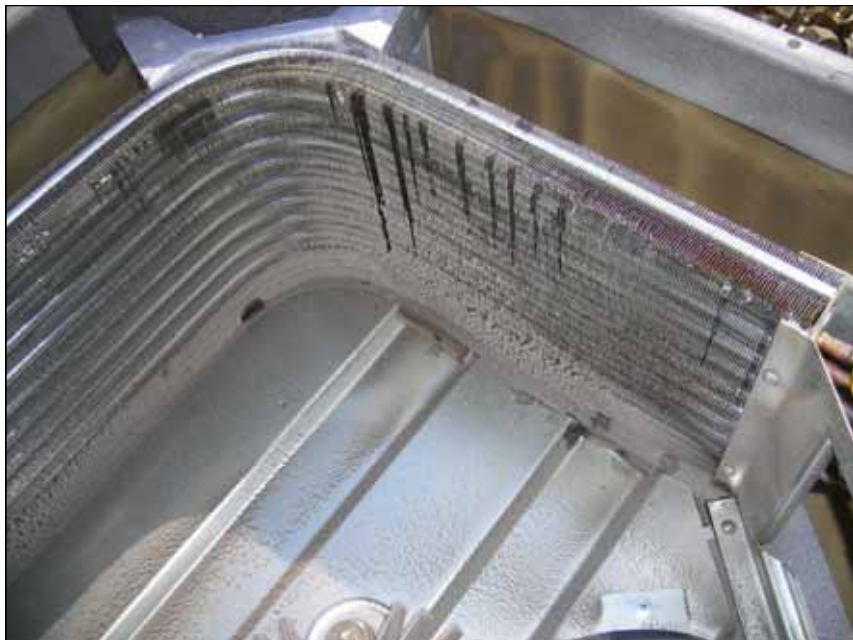
機器：エアコン室内機 作業内容：オイル薬品洗浄前
