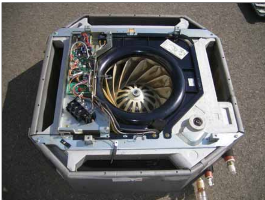
機器：エアコン室内機 作業内容：オーバーホール前
