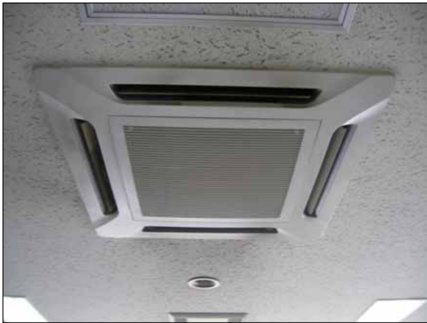
機器：エアコン室内機 作業内容：取外し前
