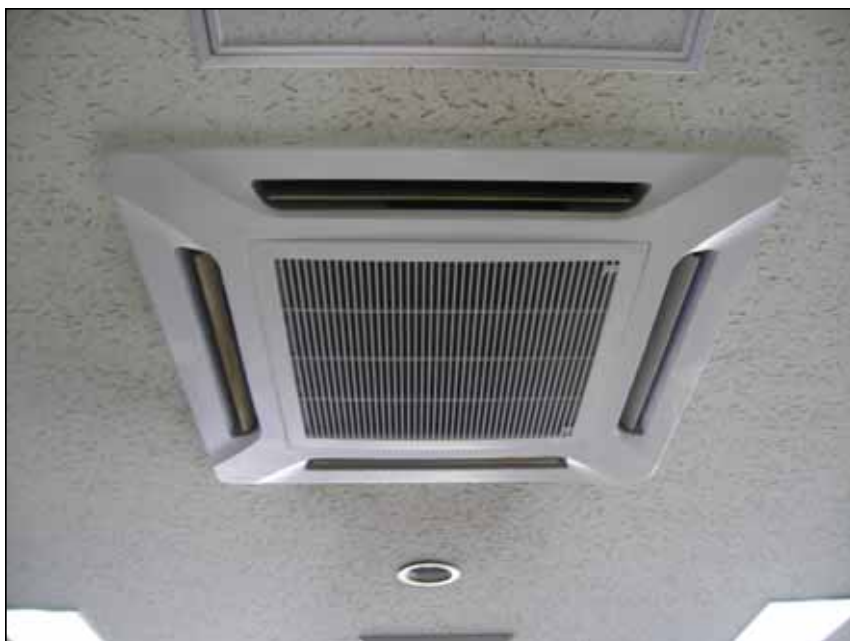
機器：エアコン室内機 作業内容：作業完了
