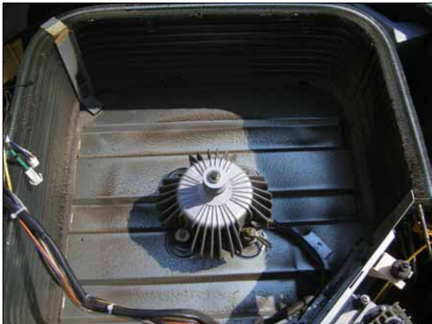
機器：エアコン室内機 作業内容：分解作業
